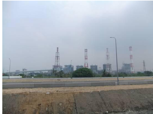
施工中的第六貨櫃中心（王安妮攝）
