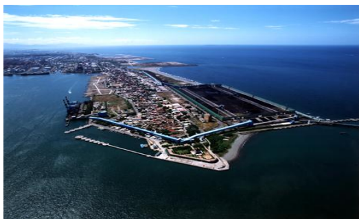
(圖：紅毛港拆除前)
